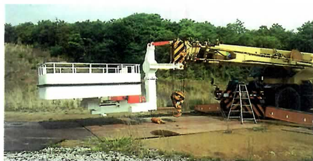
SS-300 50Tラフター取付
