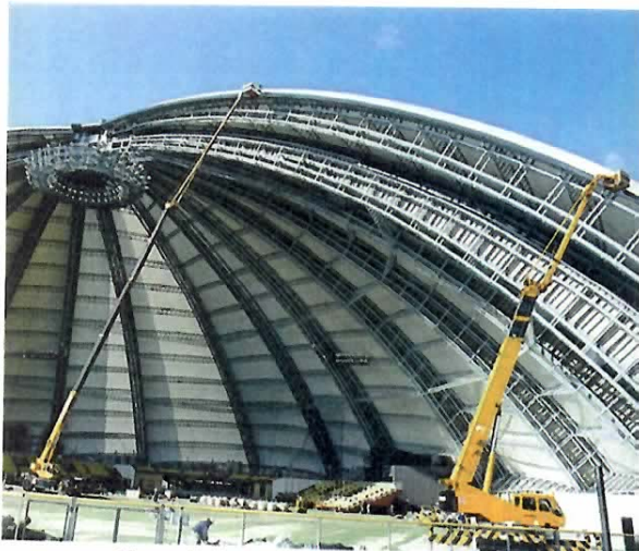
ドーム塗装 55m作業 50Tラフター
